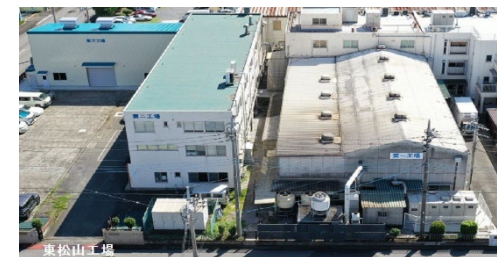
同 東松山工場 (埼玉県東松山市)
